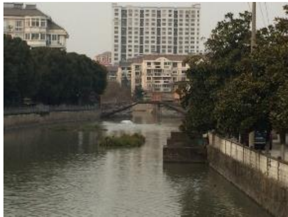
图 5-8. 乍浦镇至今依然随处可见的清代石桥
