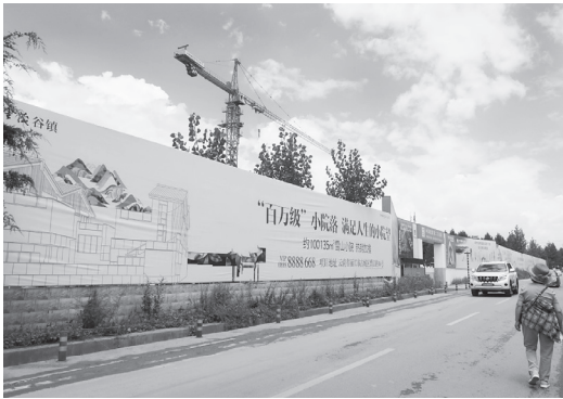
写真11 建設中のリゾート別荘 (2018年8月筆者撮影)
