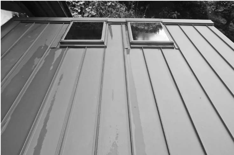
図10. ガルバリウム鋼板葺き屋根(高原家の台所、恵那市飯地町)
