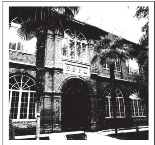
【図5】基督病院(2014年11月11日著者撮影) この建物は1892年のもので、今は鼓楼病院に保存されている。
