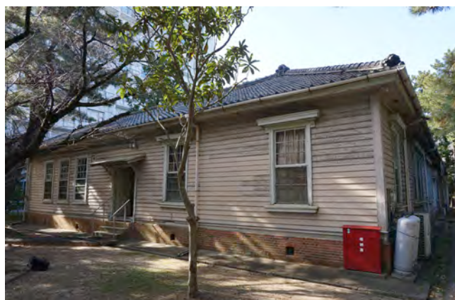
写真 9. 東側外観. 上下窓に大きな窓台とまぐさ.
