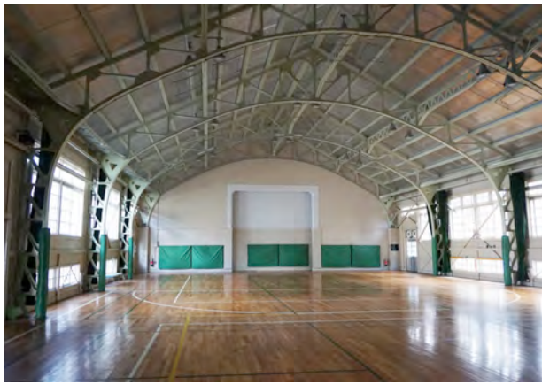
写真 25. トラスによる柱と梁の架構.
