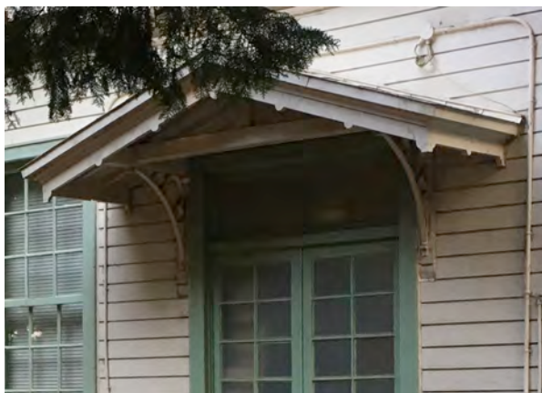
写真 17. 庇の鉄製持送り。
