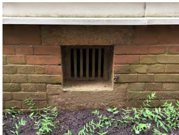
写真 18. 煉瓦布基礎に石造の換気口。
