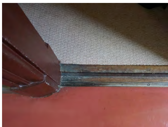
写真 20. 開口部靴刷りの鉄製レール。
