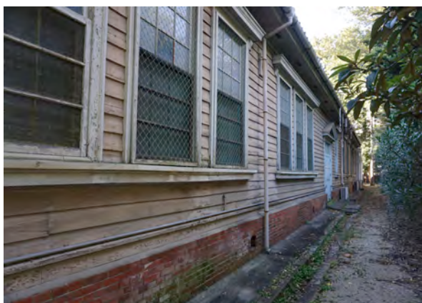
写真 8. 北側外観（正面）. 中央に玄関扉.
