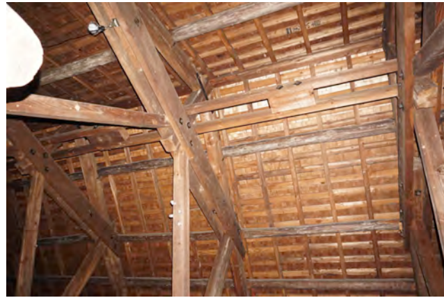
写真 14. 小屋組の様子.
