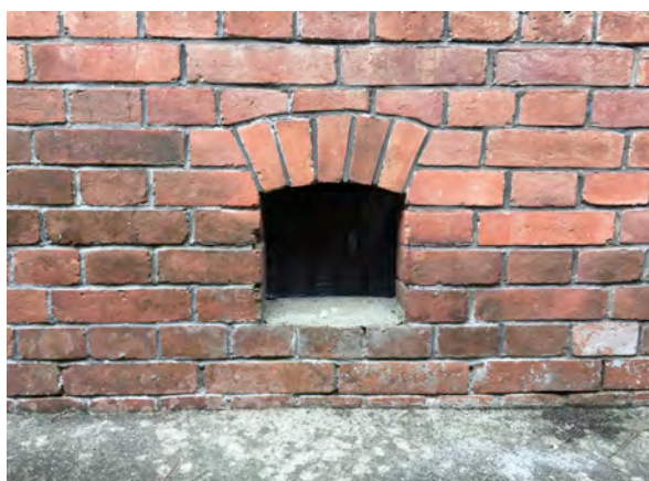
写真 11. 煉瓦基礎の換気口.
