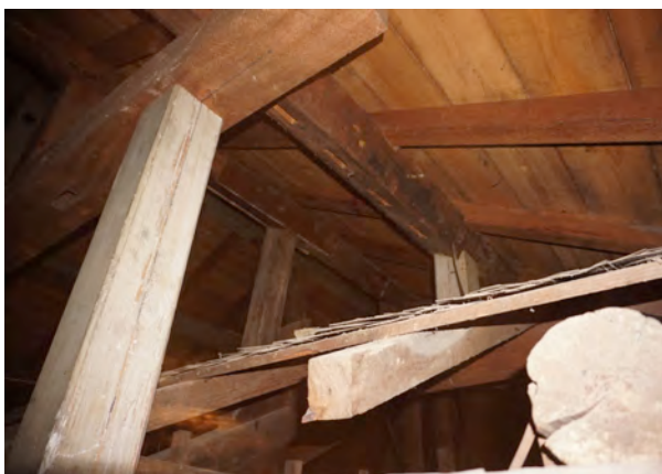
写真 12. 増築跡。野地板の上に和小屋組が載る。
