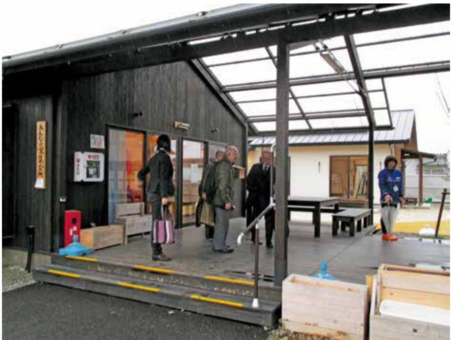
益城町テクノ仮設集会所
