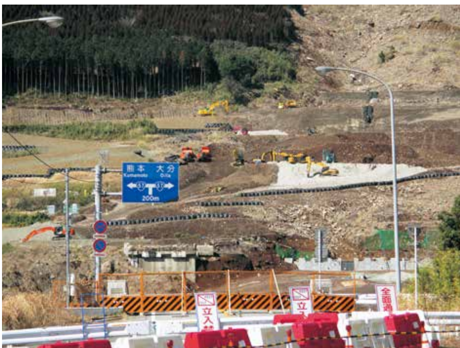
東海大学阿蘇キャンパス近くの山崩れと崩落した橋の復旧工事
