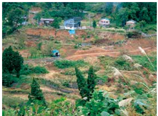
山古志支所から谷をはさんだ対岸の崩落現場
