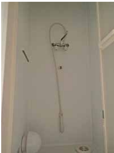
非常用のシャワールーム (危機管理センター内)
