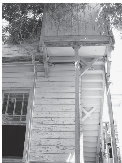
図14 避難階段の床下の木組
