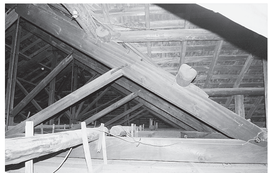
図11 小屋組 左手に鉄筋のキングポストが見える
