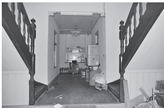
図12 階段室と手摺
