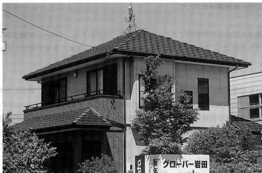
第6図 新築家屋（街でよく見かけるハウスメーカー製、 平板瓦屋根を持つ家）鬼瓦無し 愛知県豊橋市岩田地区
