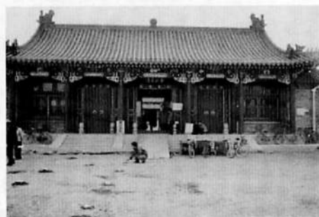
【写真41】 工事中の常営清真寺の庭・ 2004年3月
