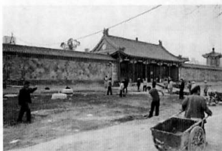
【写真40】 工事中の常営清真寺表門（東向き） とその前の道路・2004年3月
