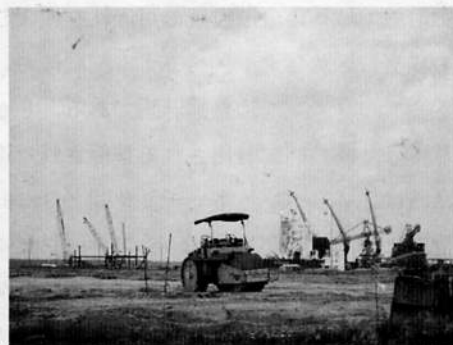
写真4 カイメップ・チバイ港建設現場 (2007年8月撮影)
