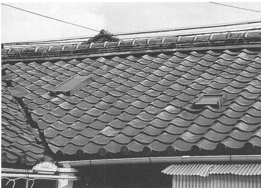
第14図 天窓を持つ屋根 杉浦彦治家
