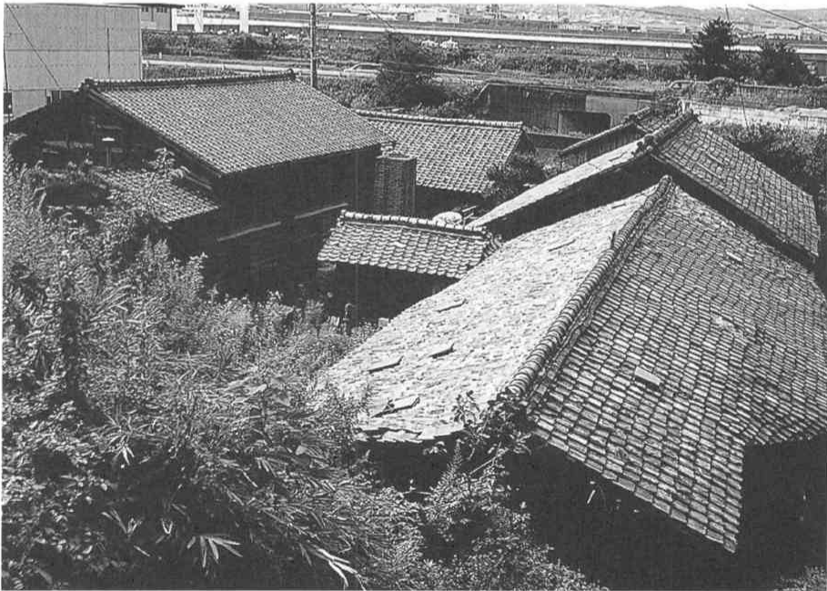
第2図 初代杉浦彦蔵瓦工場（本家と旧高浜港（写真上部分））
