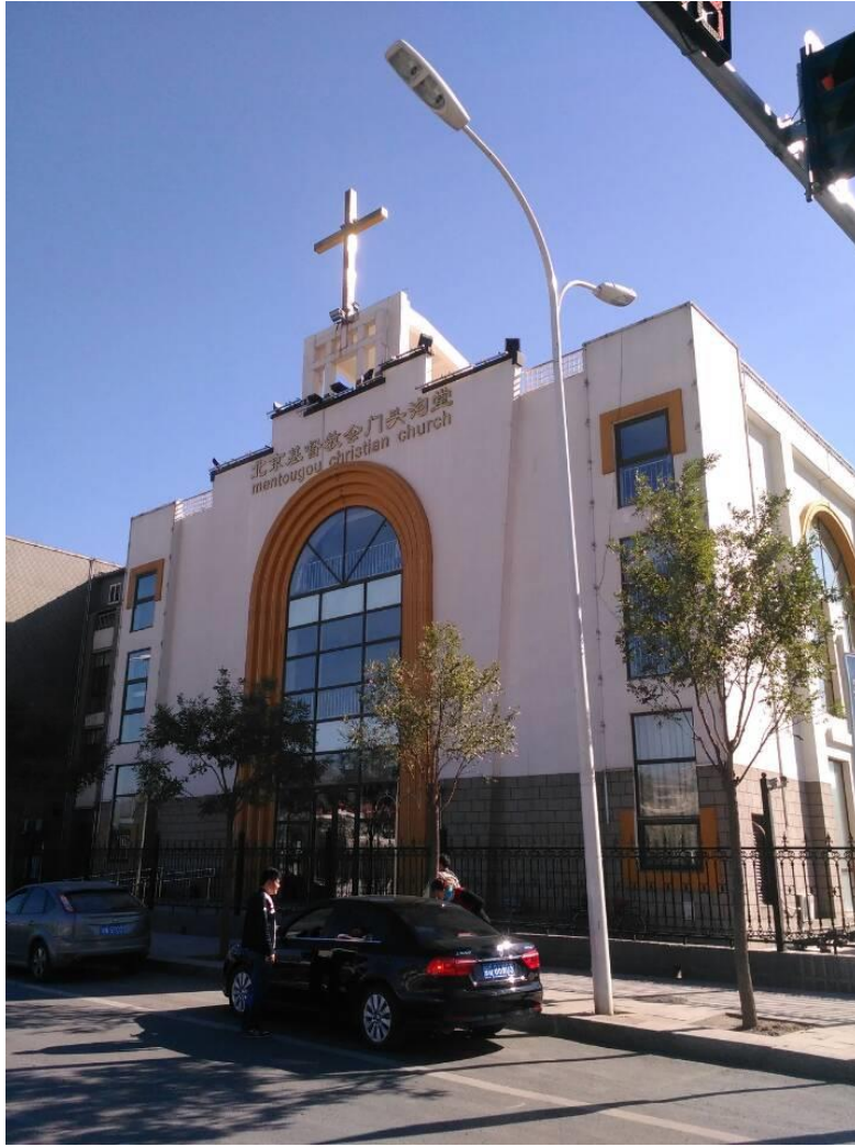
图 9：基督教门头沟区教堂外部。（作者 摄于 2011 年）。
