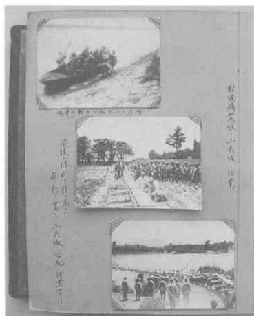
写真8 工兵隊による架橋作業
