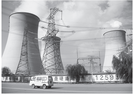
写真2 内モンゴル自治区西部のダラト発電所
