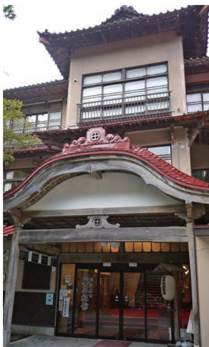
図1 藤三旅館正面入口 木立の中に木造三階建ての建物が聳える
