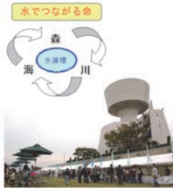
鳴海配水場のエコ市 水の循環＝経済(お金)の循環
