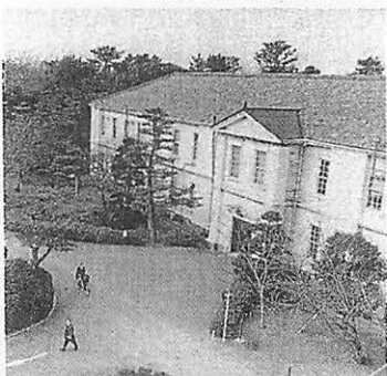
豊橋の愛知大本館
