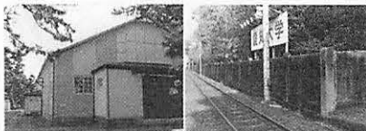
陸軍教導学校時代に建設された愛知大学施設 （左）講堂（現第二体育館）（右）コンクリートの壁
