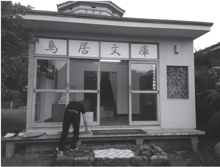
鳥居観音境内にある鳥居文庫の外観。
