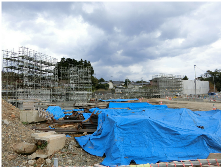
写真1 被災集落防潮堤建設の様子 撮影:加藤旭人(2017年10月15日).
